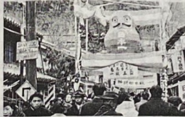
大ダルマ (山陽道の標識が左側に見える)
